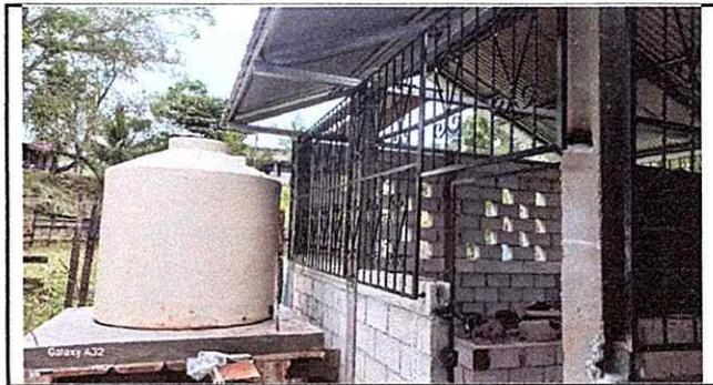
Foto 6: SE PREPARO LA BASE DEL DEPOSITO DE AGUA Y SE INSTALO ENFRENTA DE LA COCINA EL TINACO COMPRADO.
