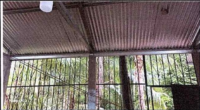
Foto1: EN AREA DE COCINA SE SE INSTALO BALCONES A TODAS LAS VENTANAS DESCUBIERTAS, YA QUE NO ESTABA ASEGURADA,
