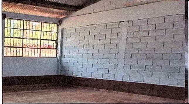
Foto 2: LA ESTRUCTURA DE TECHO NO SE REALIZÓ, YA QUE SE PRIORIZÓ EL CIERRE CON BLOCK LAS DIVISIONES DE LOS SALONES DE CLASE.
