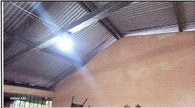
Foto 4: SE INSTALO EL CABLEADO E ILUMINACION EN EL SALON #4 Y EN LA COCINA CON SU RESPECTIVO TOMACORRIENTE.
